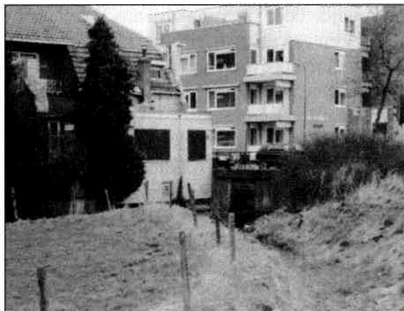
De Houtringervaart met sluisje, gelegen aan de oostzijde van de bebouwing van de Dorpsstraat vanouds Steenstraat 1-3. Foto februari 2000.
