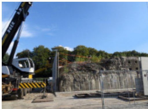
'Inpakken' van de door explosie beschadigde bunker (foto: garage De Bilt).
