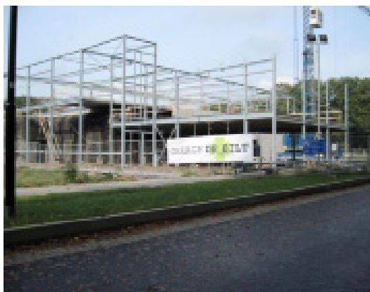
Garage De Bilt in aanbouw (2013); binnen het metalen geraamte voor de nieuwbouw is de bunker nog goed zichtbaar (Foto: R.H. Rijntalder).
