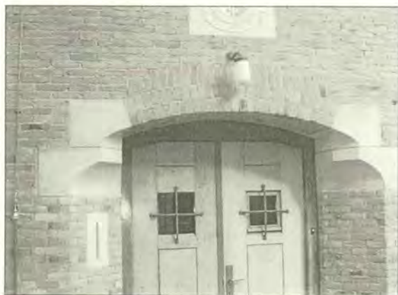
Detail centrale ingangsdeuren
