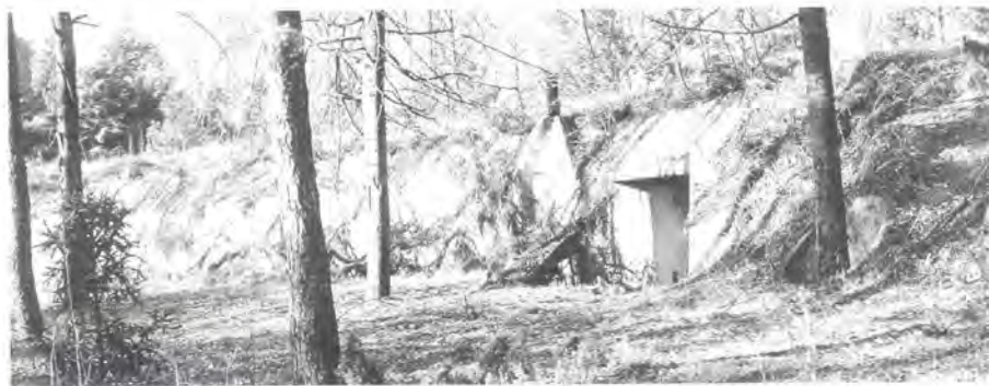
De hoofdbunker B1, afmeting 32 x 13 m.
