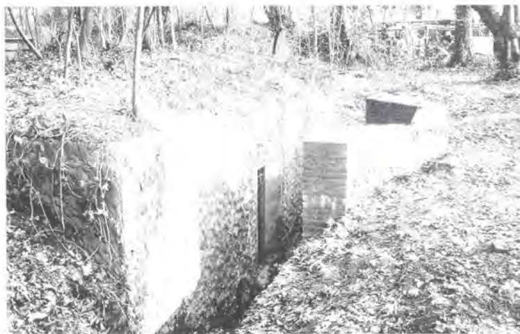
B 12. Ziekenboeg (Sanitätsbunker). Direct herkenbaar aan de gebroken scherfmuur. Hierdoor kon je beter met een brancard binnen komen. Was toch al moeilijk via de lange trap!
