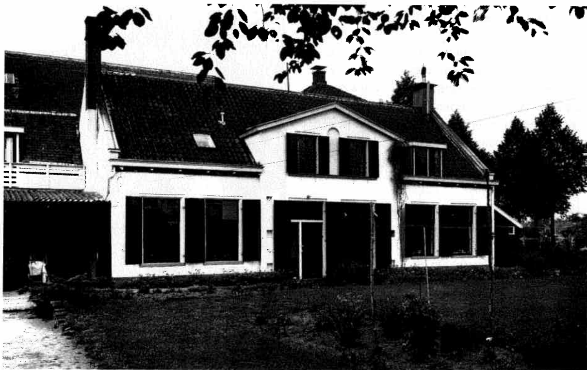
Achtergevel van het pand Meijenhagen aan de Groenekanseweg. Rechts is nog een gedeelte van een ingangsportaalje zichtbaar. Foto juni 1954 (fotoarchief Rijksdienst voor de Monumentenzorg Zeist; negatief nr. 51350).
