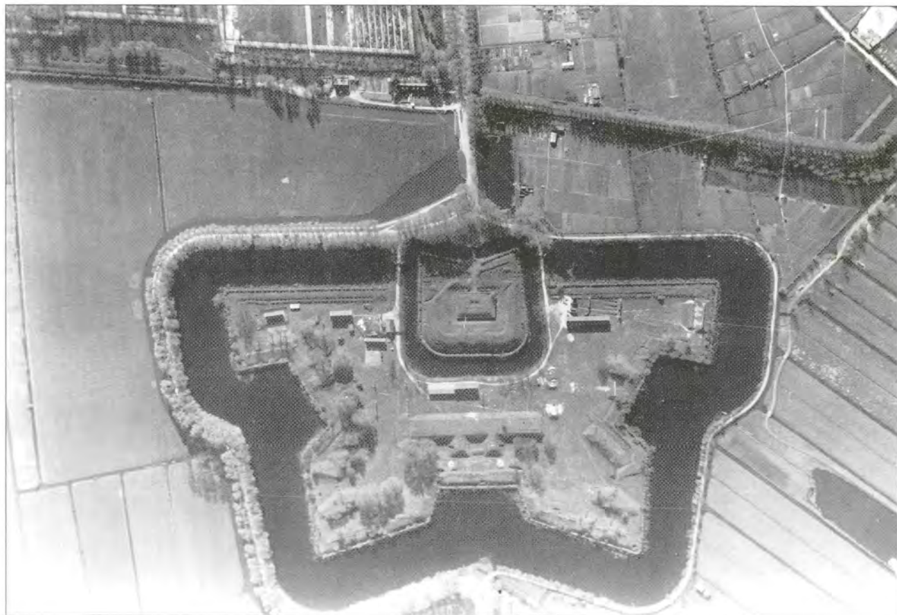
Fort De Bilt: Fort De Bilt vóór de aanleg van de Biltsestraatweg door het fort <1929>. Onderkant foto: richting De Bilt.
